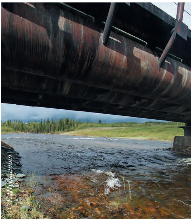
Мост через Щугор.
