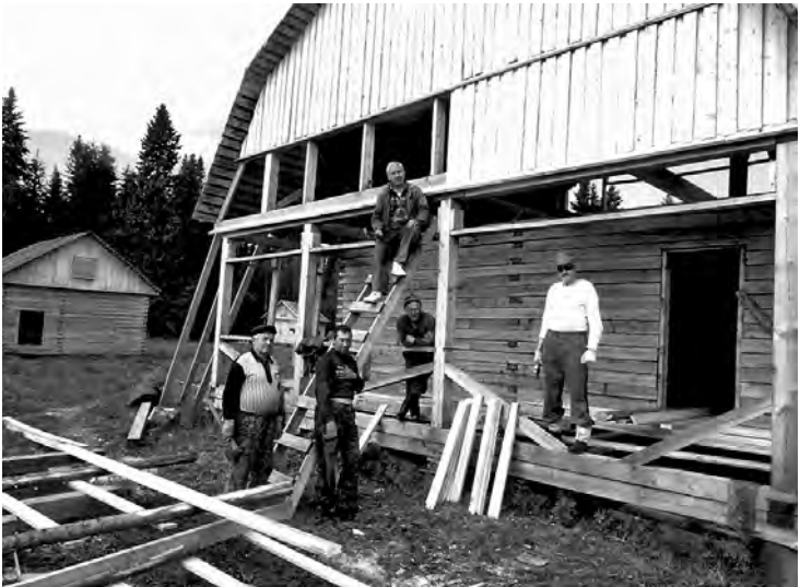
Строительство нового дома для туристов в Мичабичевнике. 2007 г..
