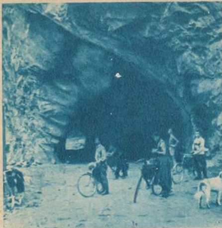
Тоннель в Кассарском ущелье Фото А. Дементьева
