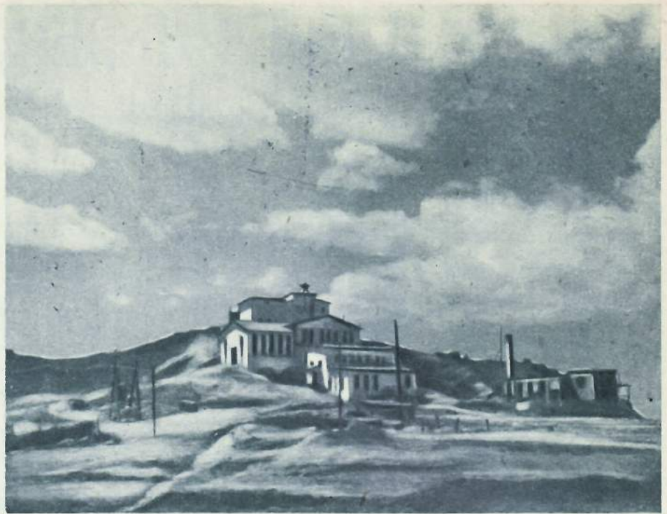
Обогатительная фабрика Прибалхашстрой
