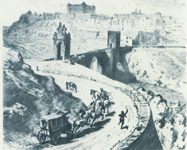
Мост через реку Тахо у г. Толедо
